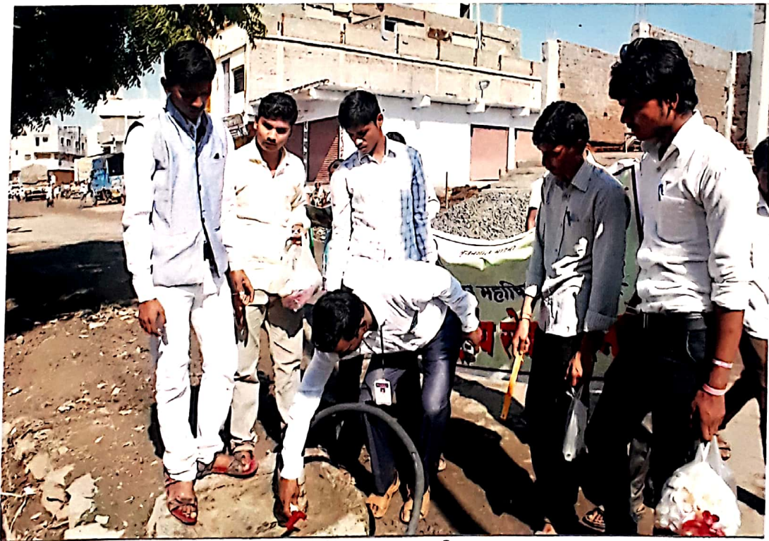
देगलूर शहरात नळांना तोटी बसवताना स्वयंसेवक जं. बालाजी कन्नरवार
